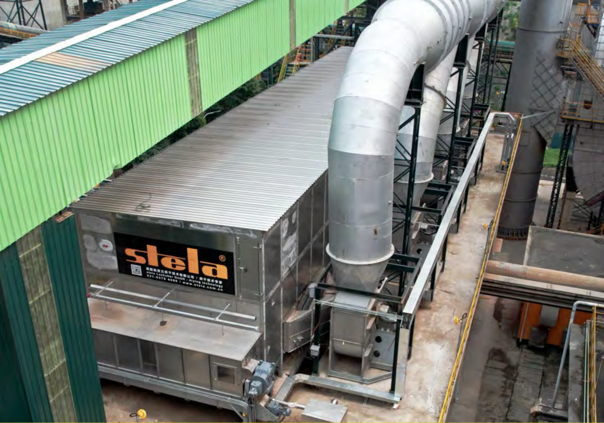
项目地：台泥贵港水泥，中国 | 型号：BT 1/6200-30 | 安装年份：2022 干燥物料：RDF垃圾燃料和树皮混料 | 出料能力：约12.4吨/小时 | 降水区间：50% - 15%湿度
